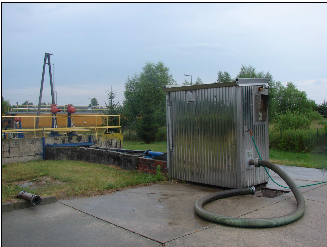
Fot. Elementy punktu zlewnego: stacja kontenerowa + kanał dopływowy.
